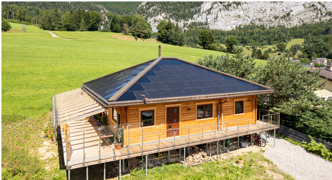
Abbildung 11: Schrägdach Indach PV, Einfamilienwohnhaus Welschenrohr Rötistrasse. Solstis ®
