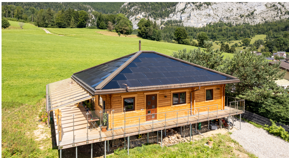
Figure 11 : installation PV intégrée en toiture inclinée, maison individuelle Welschenrohr, Rötistrasse. Solstis ©
