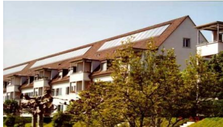
Genossenschaft Hofgarten Zürich, 300 \text{ m}^2 Kollektoren (Brauchwasservorwärmung)
