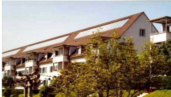
Genossenschaft Hofgarten Zürich, 300 m 2 Kollektoren (Brauchwasservorwärmung)
