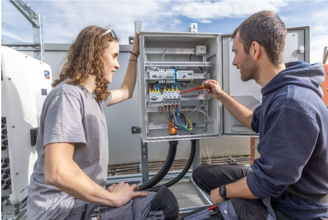
Controllo del cablaggio
