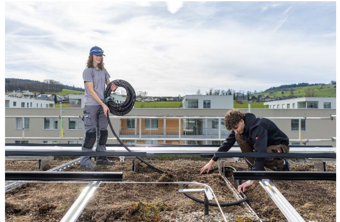
Preparazione del cablaggio
