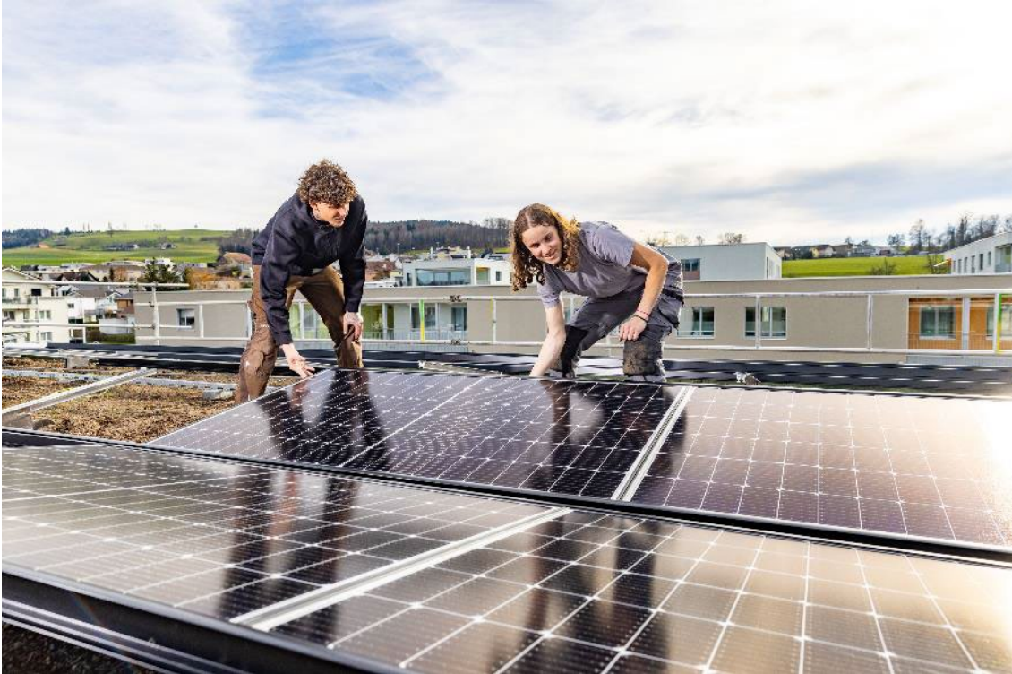
Posa dei moduli
