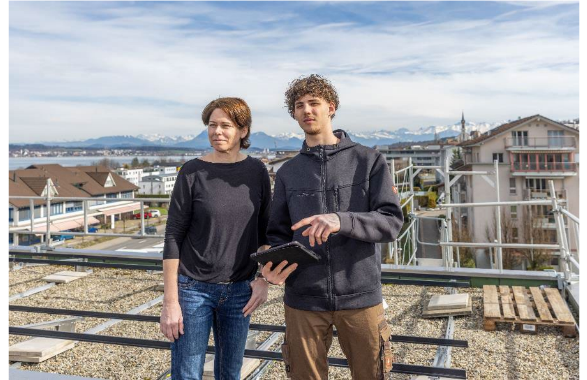
Preparazione e coordinamento dei lavori
