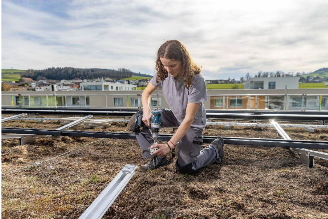
Montaggio struttura di fissaggio dei moduli
