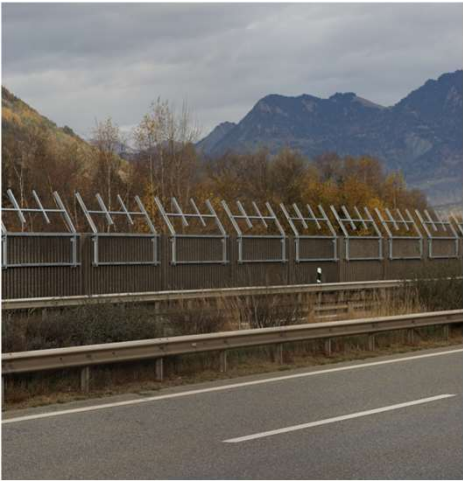
N13 Lärmschutzwand 2.Etappe (in Bau), Felsberg (GR) Foto: Rhienergie AG
